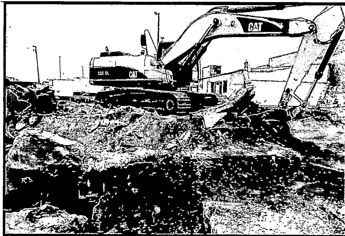
DEMOLICION DE CIMENTACIONES Y CORTE MASIVO
