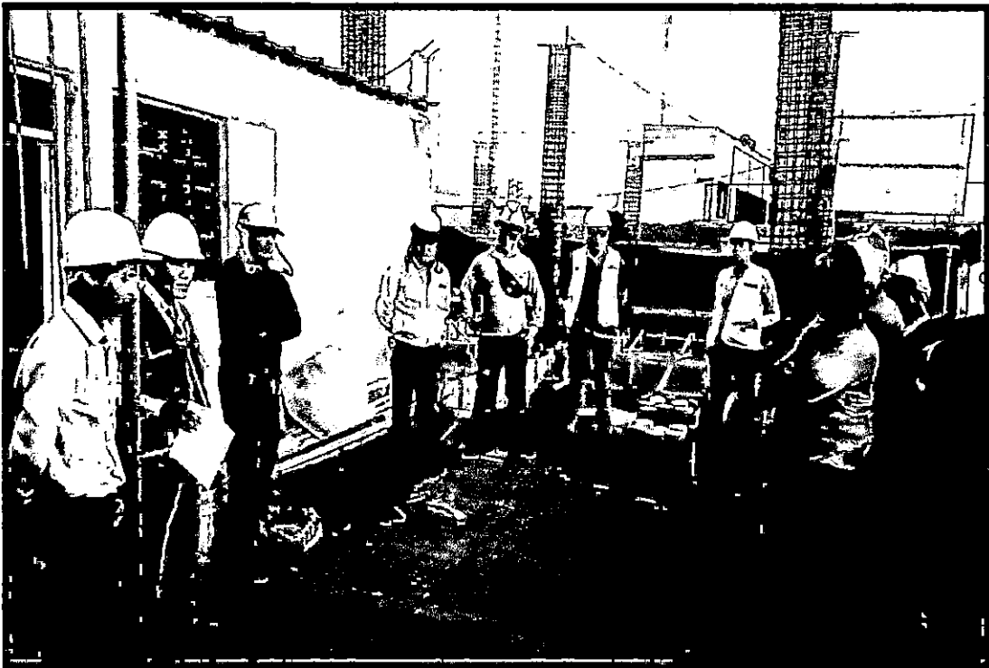
CAPACITACION EN SEGURIDAD CON PARTICIPACION DE LA SUPERVISION DE OBRA
