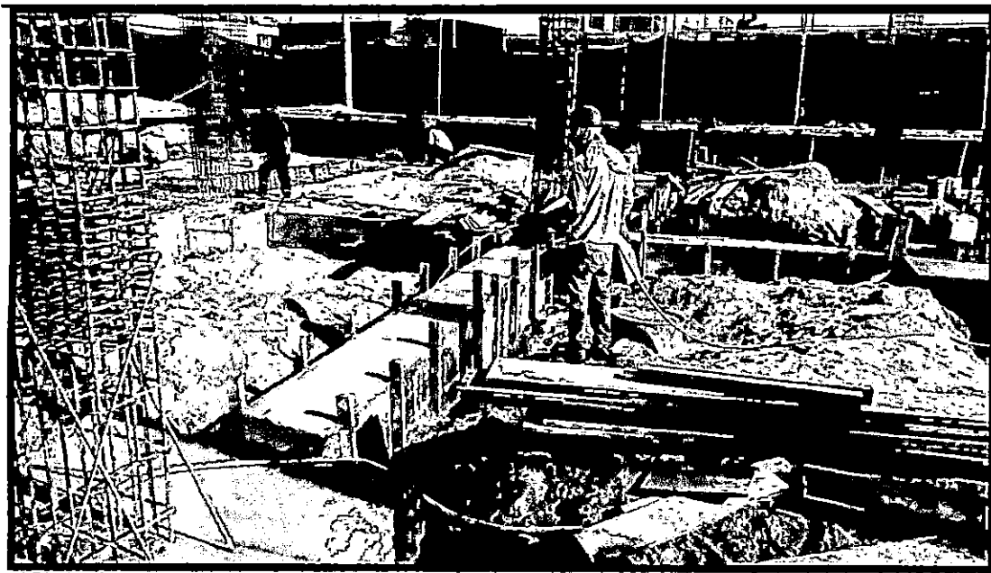
CURADO DEL CONCRETO CICLOPEO f'c=140 \text{ kg/cm}^2 + 30\% \text{ P.G.}
