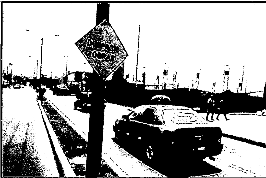
IMPLEMENTACION DEL PLAN DE SEGURIDAD, SALUD OCUPACIONAL Y MEDIO AMBIENTE Y SEÑALIZACION TEMPORAL DE SEGURIDAD
