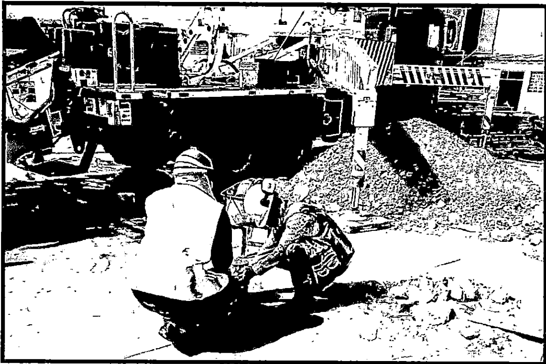
OBTENCIÓN DE TESTIGOS DE CONCRETO PARA CONTROLES DE CALIDAD DE VIGAS DE CIMENTACION
