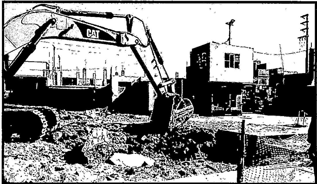
DEMOLICION DE CIMENTOS CORRIDOS
