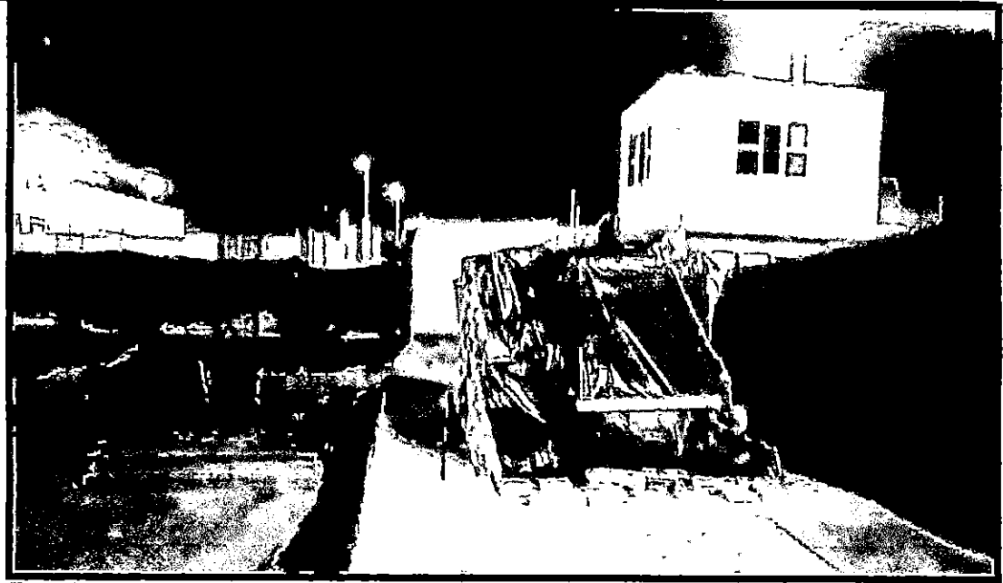
PROTECCIÓN DE BOLSAS DE CEMENTO ANTE EL INTEMPERISMO MARINO
