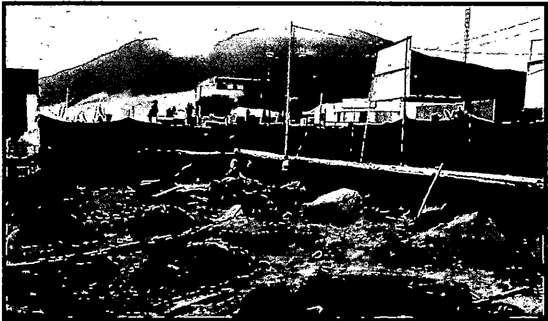
SOLADO PARA ZAPATAS DE CONCRETO E=4" MEZCLA 1:2
