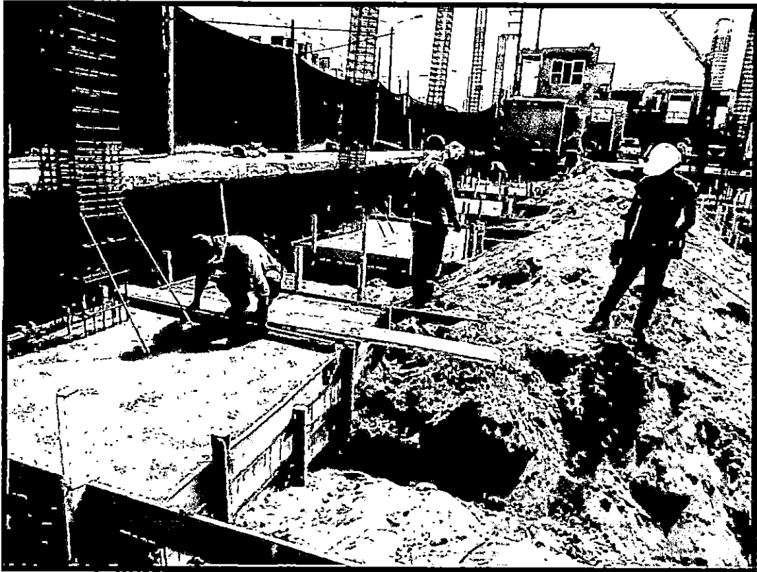
SUPERVISION DEL VACIADO DE CONCRETO f'_c=280 kg/cm 2 EN ZAPATAS
