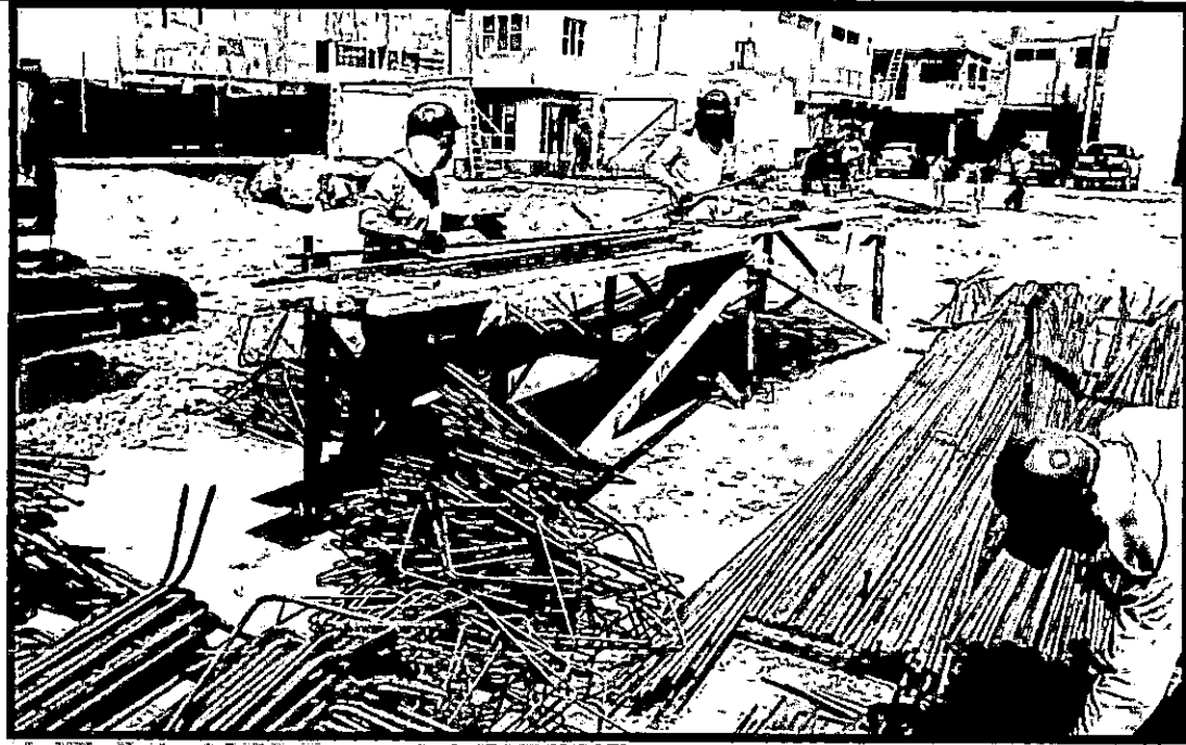
HABILITACIÓN DEL ACERO CORRUGADO FY= 4200 \text{ kg/cm}^2 EN ZAPATAS
