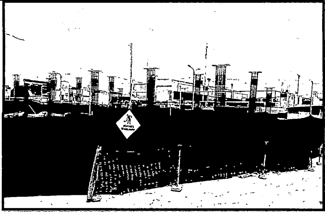
CERCO DE OBRA CON POSTES Y MALLA RASCHEL, IMPLEMENTACION DEL PLAN DE SEGURIDAD, SALUD OCUPACIONAL Y MEDIO AMBIENTE Y SEÑALIZACION TEMPORAL DE SEGURIDA
