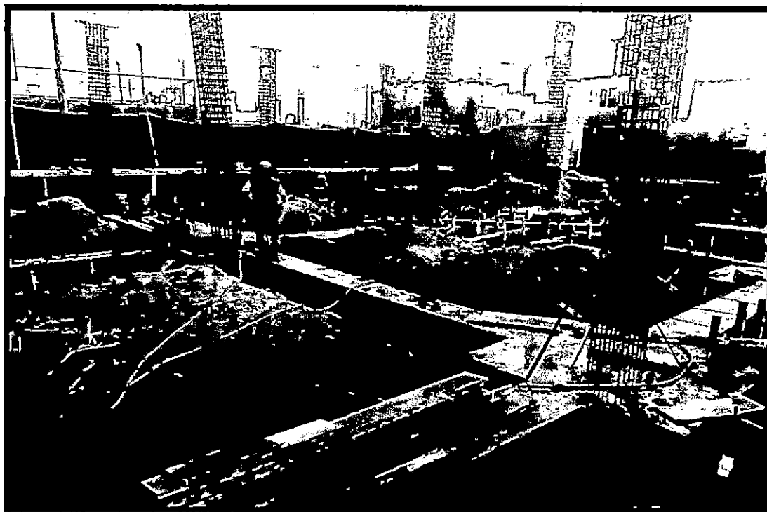
CURADO DEL CONCRETO CICLOPEO f'c=140 \text{ kg/cm}^2 + 30\% \text{ P.G.}
