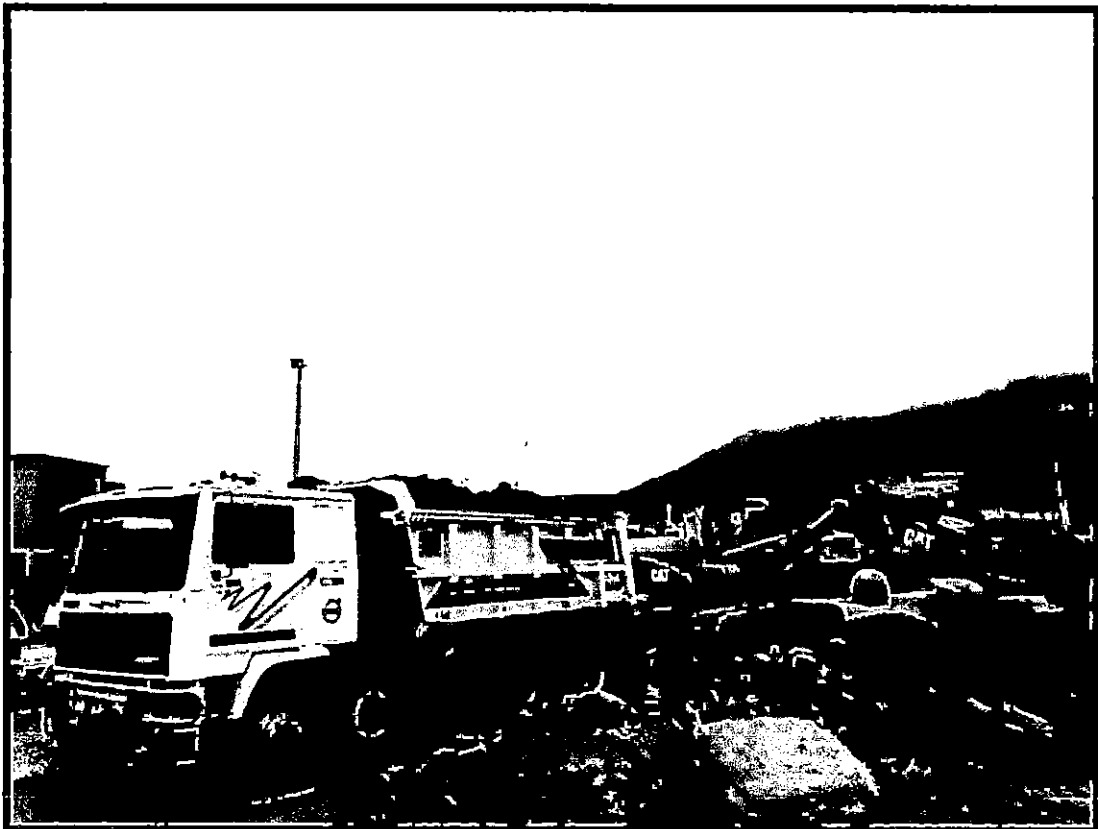
ELIMINACION DE MATERIAL EXCEDENTE CON EQUIPO
