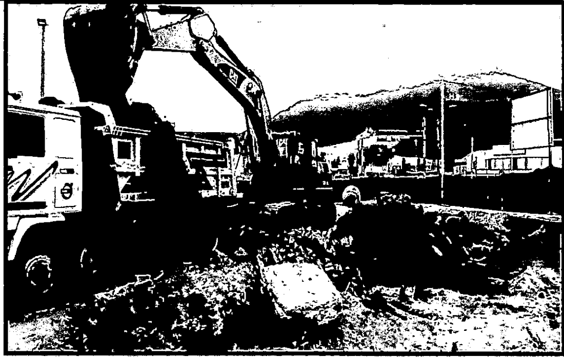
ELIMINACION DE MATERIAL EXCEDENTE CON EQUIPO
