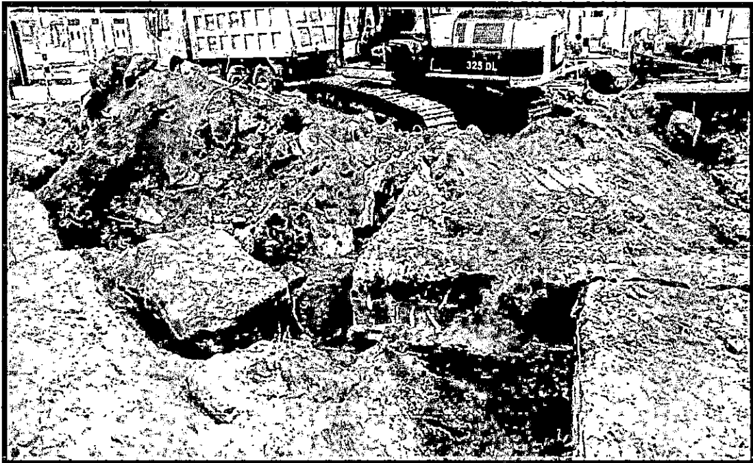
DEMOLICION DE CIMENTOS CORRIDOS
