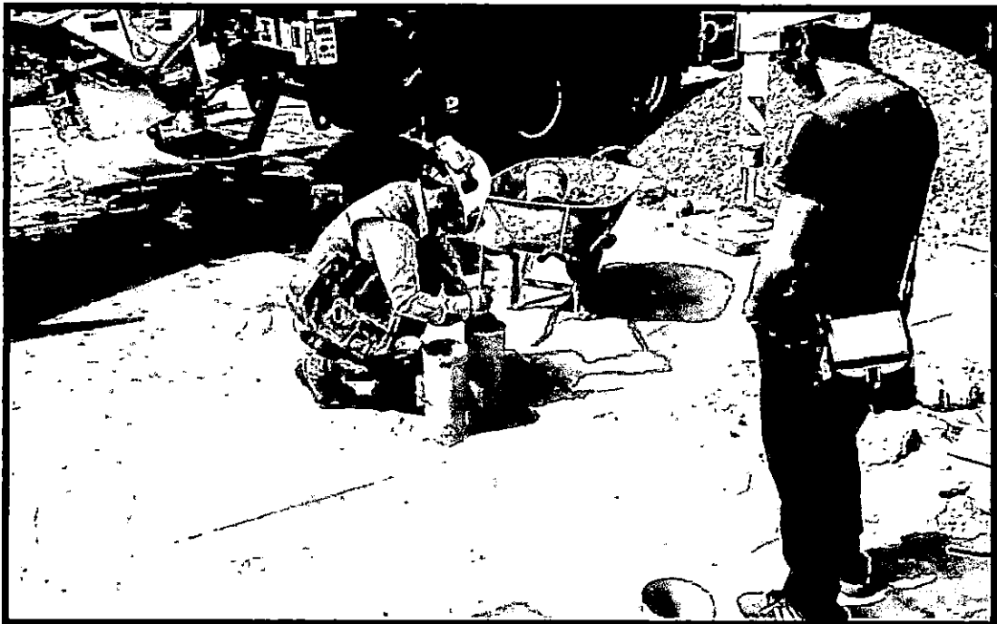
OBTENCIÓN DE TESTIGOS DE CONCRETO PARA CONTROLES DE CALIDAD DE ZAPATAS
