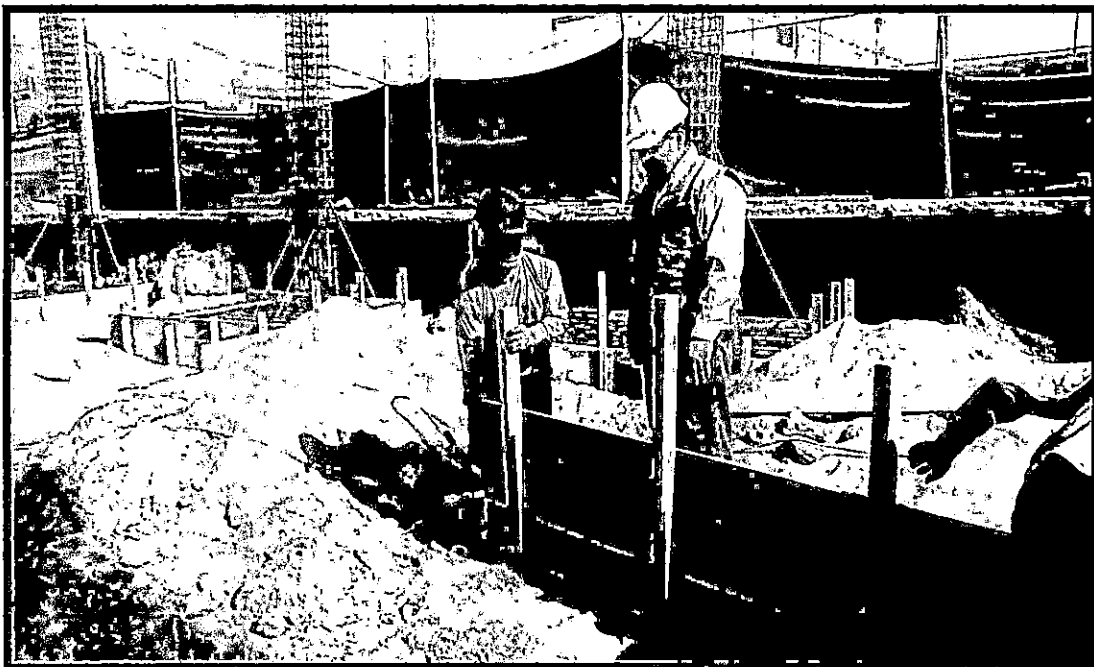
RESPONSABLE DE SEGURIDAD VERIFICANDO LA IMPLEMENTACION DEL PLAN DE SEGURIDAD, SALUD OCUPACIONAL Y MEDIO AMBIENTE, EQUIPOS DE PROTECCION INDIVIDUAL, EQUIPOS DE PROTECCION COLECTIVA Y LA SEÑALIZACION DE SEGURIDAD
