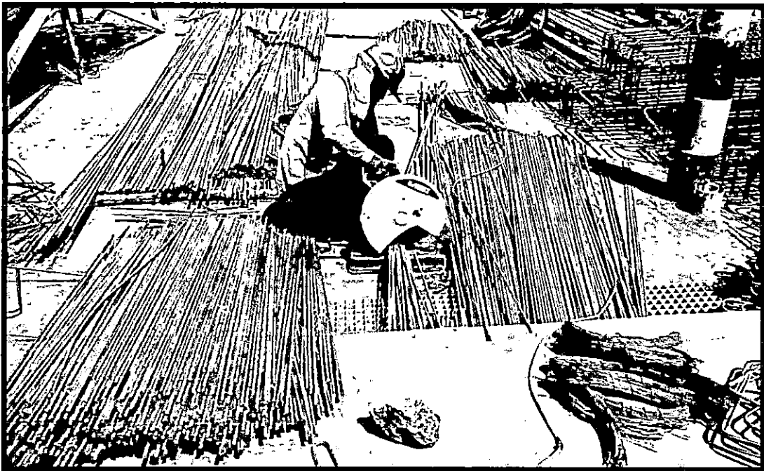
HABILITACIÓN DEL ACERO CORRUGADO FY= 4200 \text{ kg/cm}^2 EN ZAPATAS
