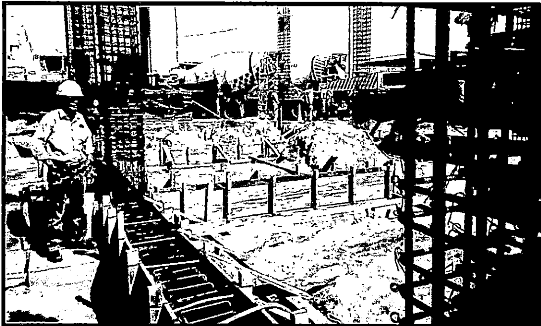
ENCOFRADO Y ACERO CORRUGADO FY= 4200 \text{ kg/cm}^2 EN VIGAS DE CIMENTACION
